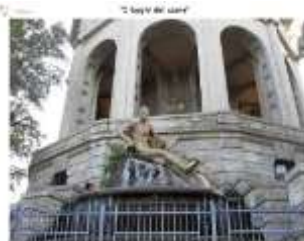
Serbatoio monumentale dell'acquedotto - Ferrara
